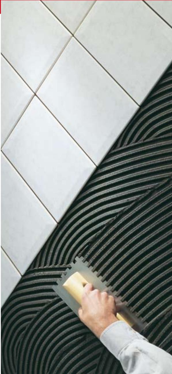
BEKRON ES UN MORTERO SECO A BASE DE CEMENTO, ARENAS Y ADITIVOS ORGÁNICOS. HA SIDO ESPECIALMENTE FORMULADO PARA ADHERIR CERÁMICOS DE TAMAÑO MEDIANO EN INTERIORES Y EXTERIORES, SOBRE MUROS DE ALBAÑILERÍA Y HORMIGÓN ESTUCADOS, LOSAS Y RADIERES DE HORMIGÓN.
